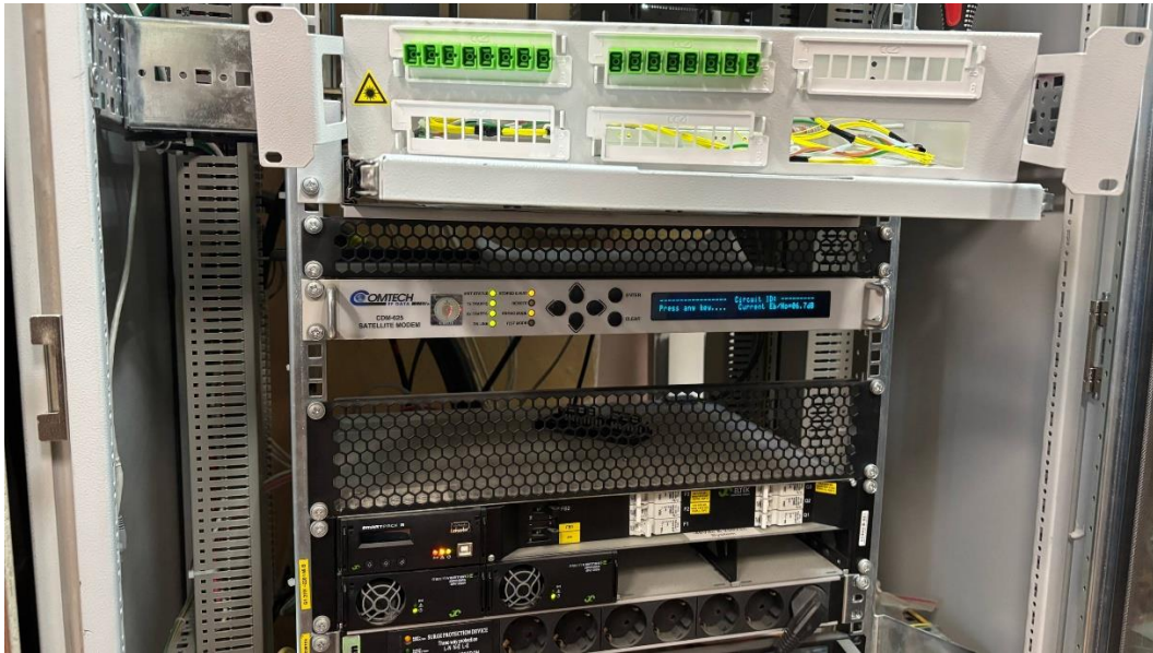
Фото 6.1.4. Организация передачи данных по оптическому каналу ПС 110 кВ Прима – РП 110 кВ Билибино
