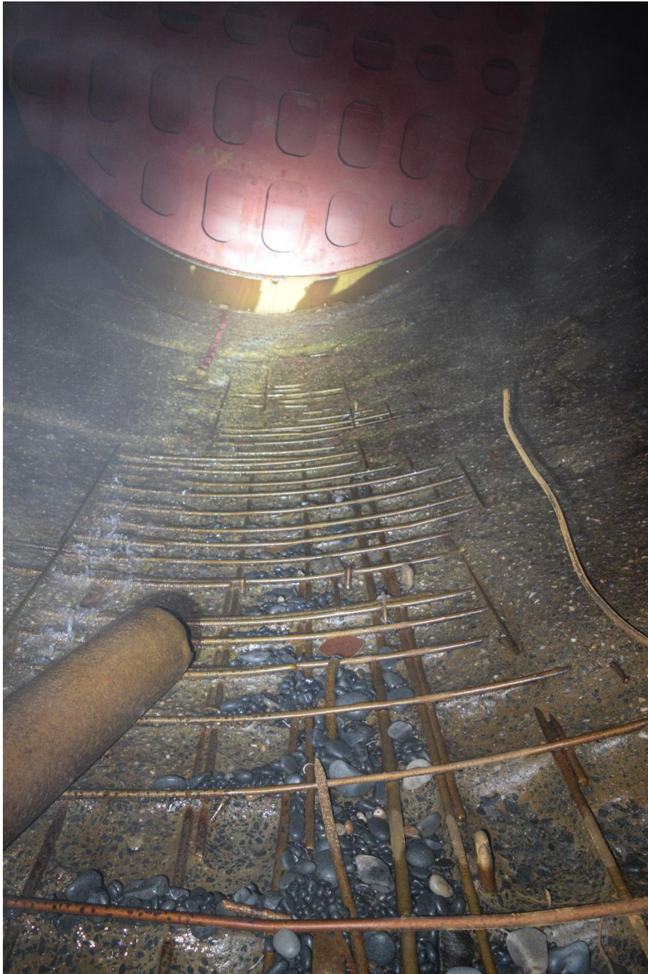
Фото 2. Участок, подлежащий ремонту в лотковой части (вид снизу)
