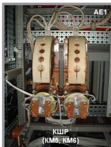
рис. 1.3. Контактор, шунтирующий ротор (КШР) типа KM2146-48-M4.
