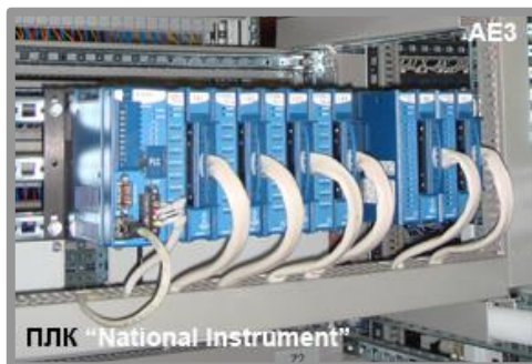
рис. 1.9. Программируемый логический контроллер ПЛК.
