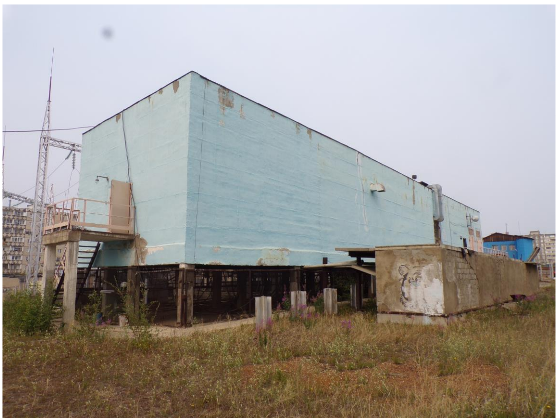
Фото 4. Общий вид фасадов здания в осях «Б-А/1» и «А/1-8».
