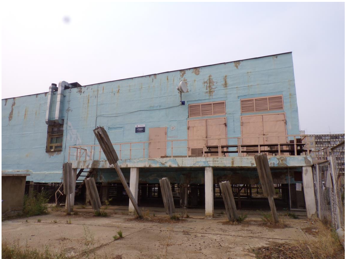
Фото 1. Общий вид фасада здания в осях «А/1-8»
