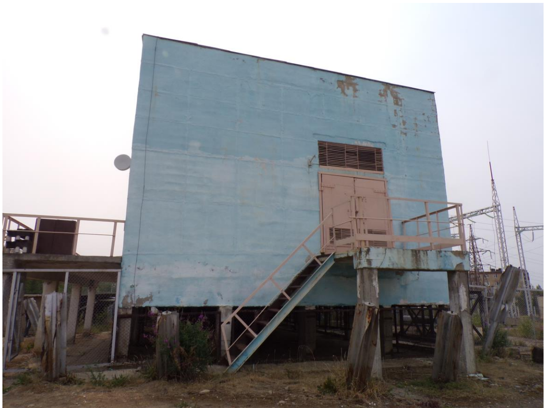
Фото 2. Общий вид фасада здания в осях «А-Б/8»
