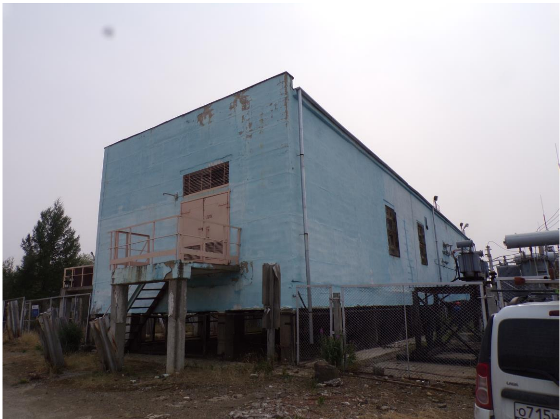
Фото 3. Общий вид фасадов здания в осях «А-Б/8» и «Б/8-1»
